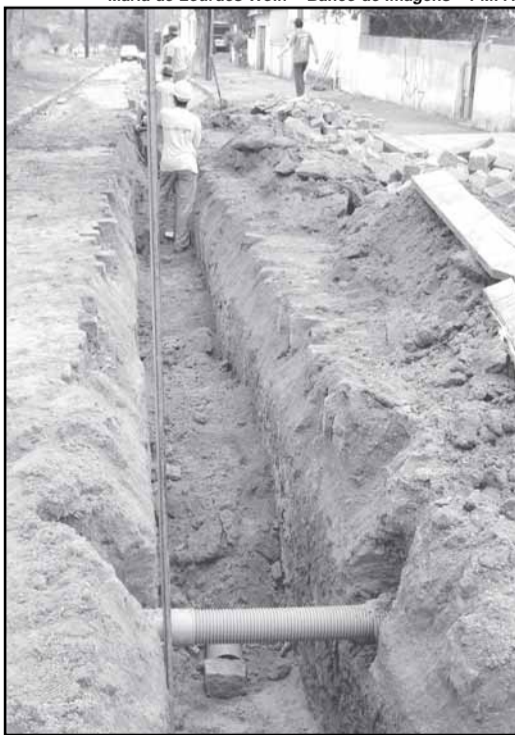
Na restinga: dos 80 quilômetros de redes coletoras previstos, 60 já foram concluídos
