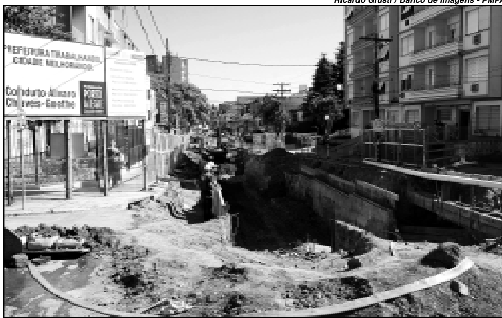
Conduto Álvaro Chaves-Goethe está entre as obras beneficiadas
