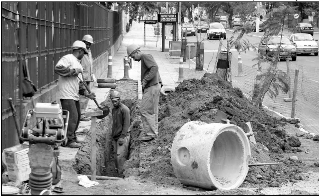
A rede terá cerca de 8,2 quilômetros km e prevê 382 ligações domiciliares
