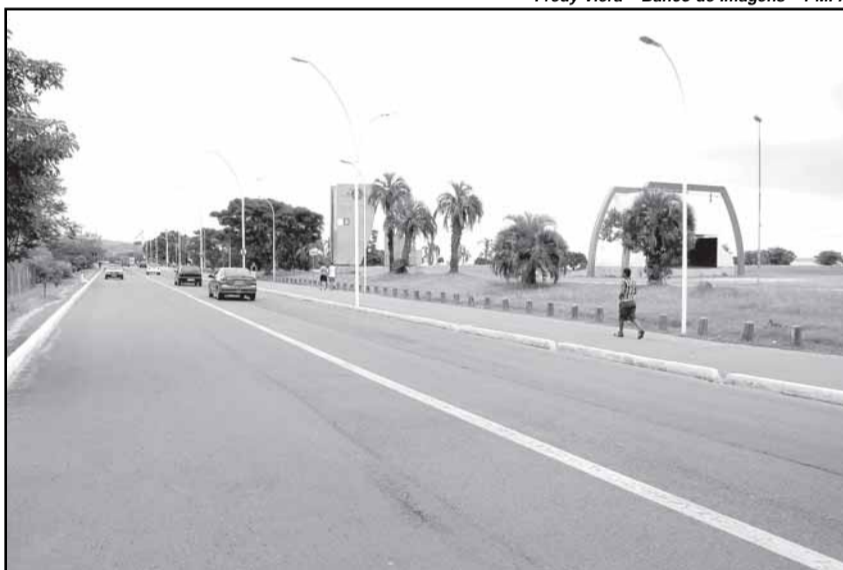
Duplicação da Beira-Rio é uma das principais obras visando à Copa
