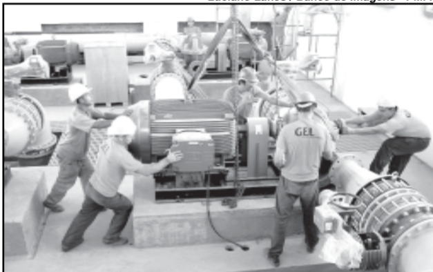
Manutenção em adutoras e estações elevatórias é periódica
