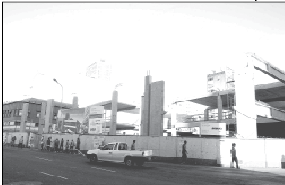
Obras do Centro Popular de Compras estão adiantadas
