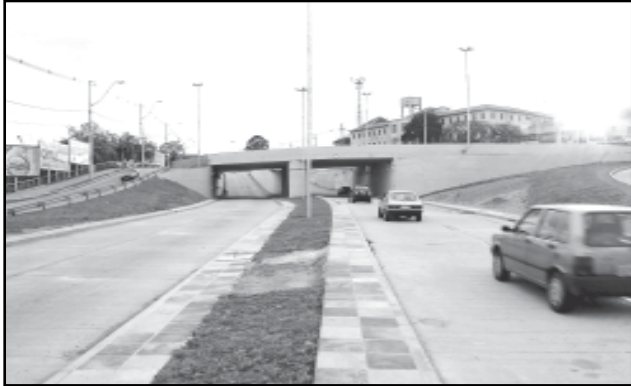
Passagem de nível Celso Furtado foi a última etapa da Terceira Perimetral
