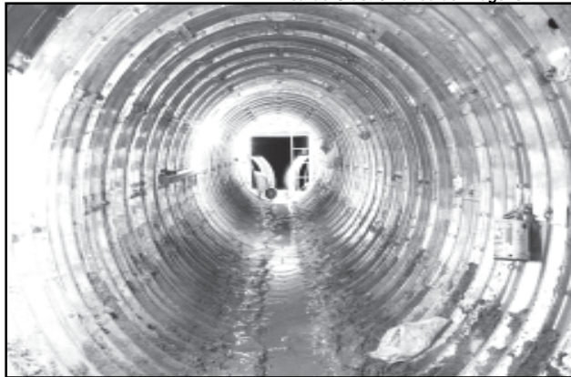
Obras do Conduto Álvaro Chaves-Goethe chegam ao seu final
