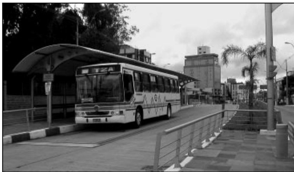
Primeiro lote da Linha T2A, que entrou em operação
