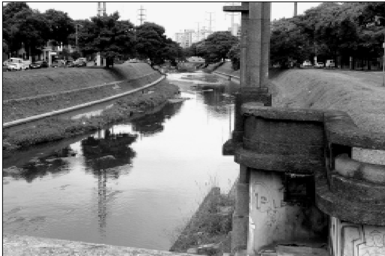
Projeto vai elevar a capacidade de tratamento de esgotos
