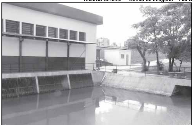
Qualificação das Casas de Bombas do DEP está em fase de licitação.
