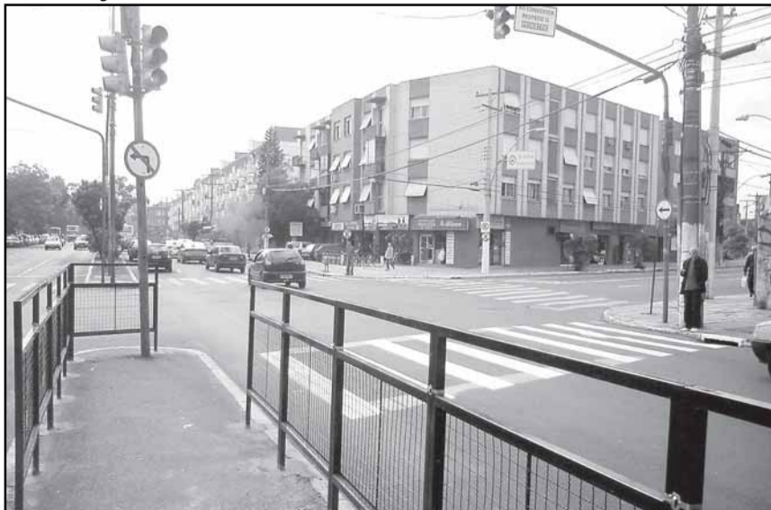
Já foram instalados 829 gradis para direcionar a travessia de pedestres, em 2010
