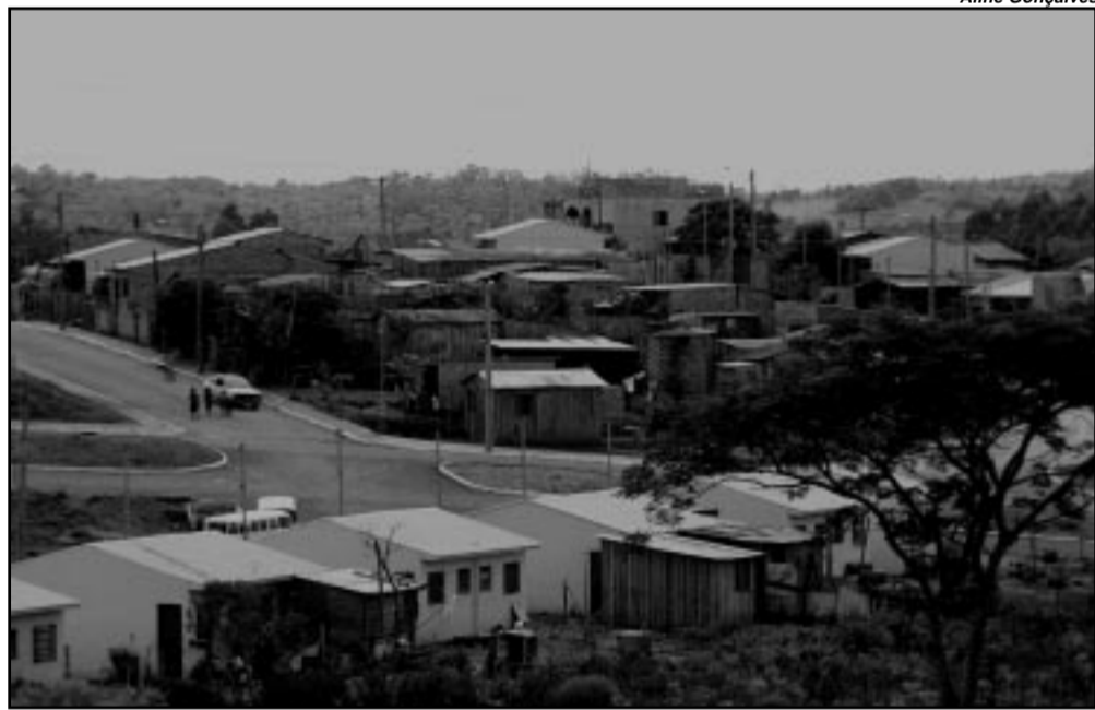
Melhorias incluem construção de moradias, além de pavimentação e saneamento
