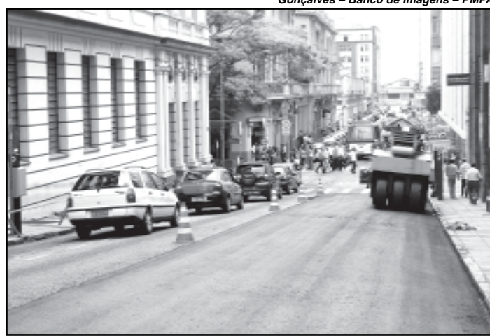
Revitalização asfáltica começou pelo centro da cidade
