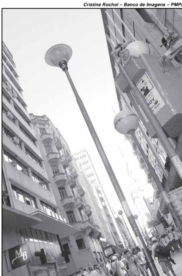
Rua dos Andradas recebeu novos equipamentos de iluminação no ano passado
