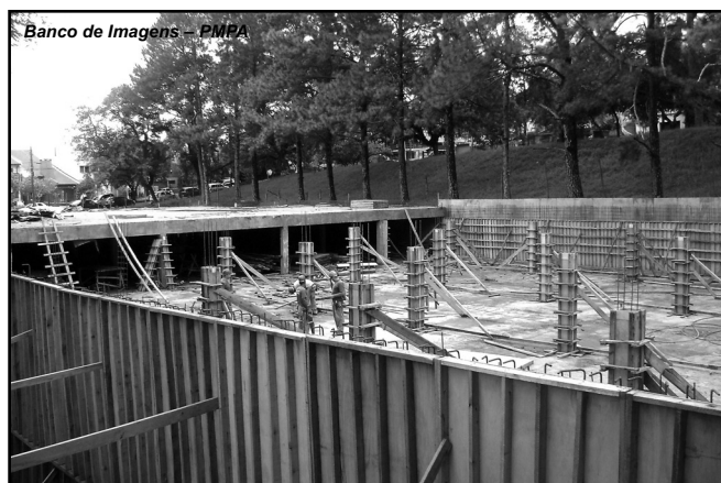
Bacia tem capacidade para deter 5 milhões de litros de água da chuva
