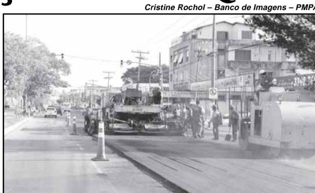
No eixo ambiental, destaque para a revitalização asfáltica de 60 quilômetros de vias de grande fluxo
