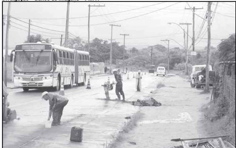
Obras de abastecimento de água estão distribuídas pela cidade
