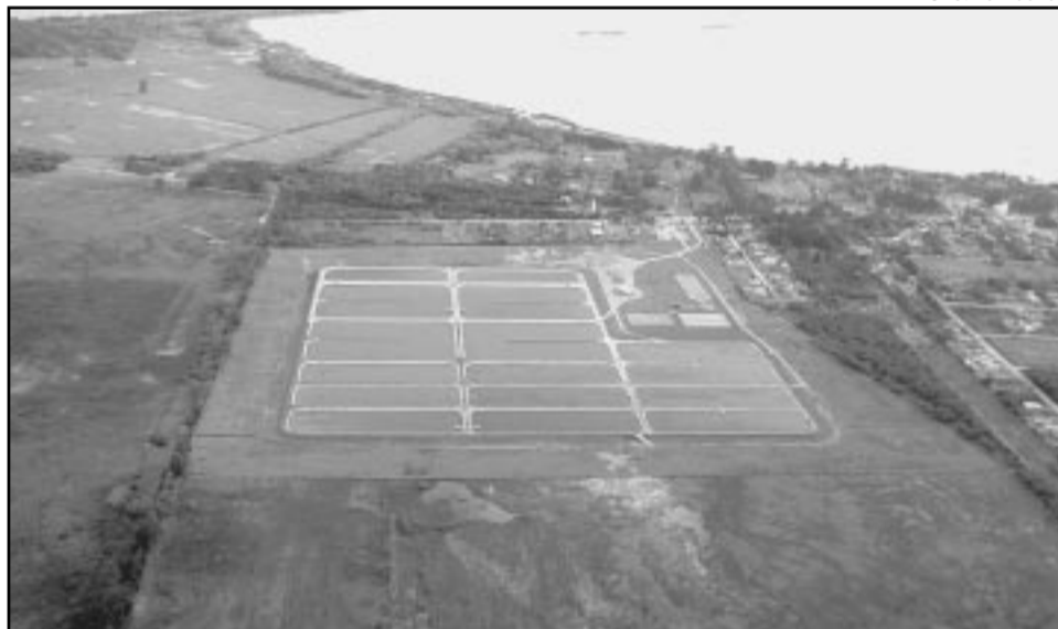
Realizado em estações, tratamento do esgoto pode ser visto pelo público
