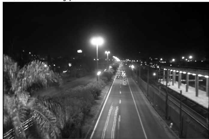
Avenida dos Estados já conta com a nova iluminação
