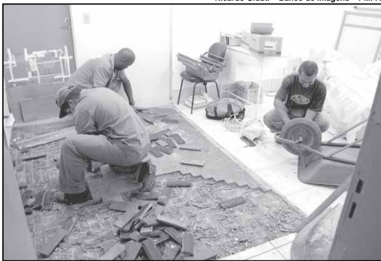
Estão sendo recuperadas a fachada do prédio, a recepção, com a troca do piso, rebocos e pintura
