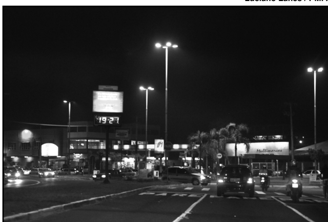
São 370 luminárias instaladas em postes de 12 metros de altura
