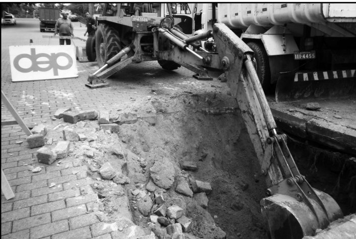
Previsão é de que o poço de transição fique pronto até o final deste mês
