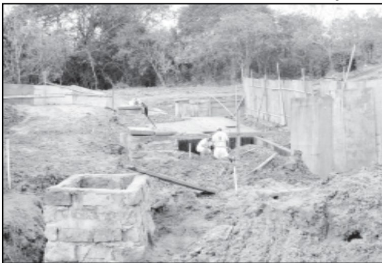
As obras de infra-estrutura têm custo estimado em R$1,5 milhão
