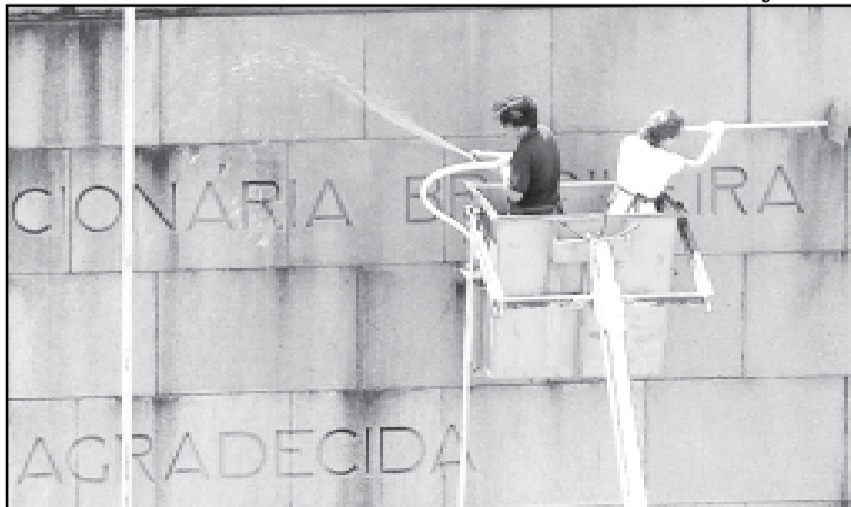
Trabalho será feito em caminhão equipado com cesto aéreo e compressor de água quente
