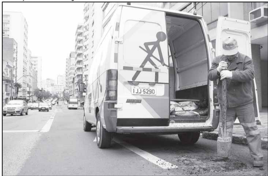
Mais três vans Tapa Buracos estarão atuando nas ruas
