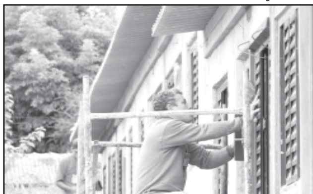
Obra na Cristiano Kraemer (Residencial São Rafael)
