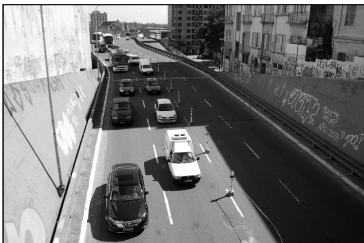
Durante o recapeamento, trânsito nas elevadas será reduzido a uma faixa
