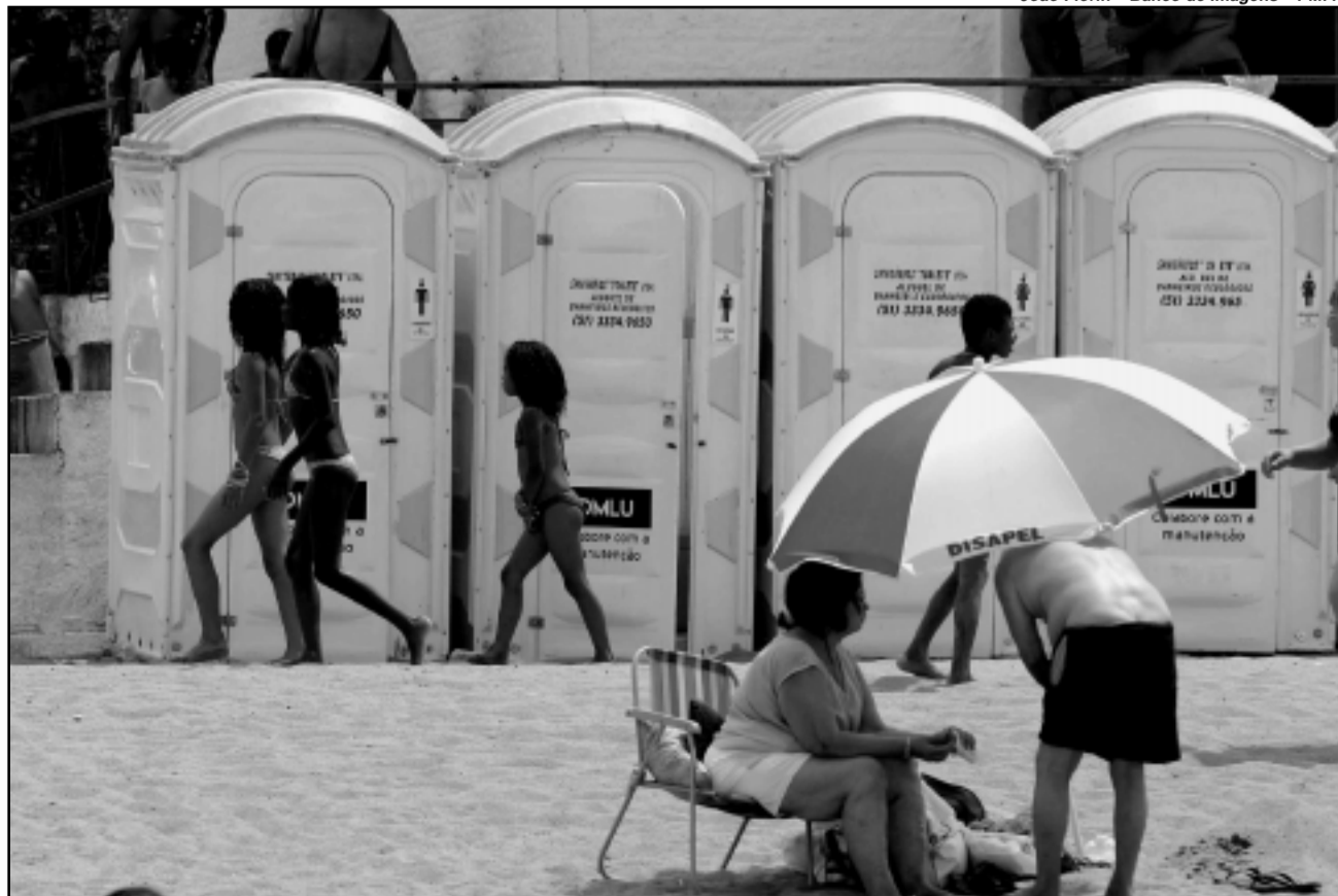
Foram instalados sanitários por toda a orla, desde a Usina do Gasômetro até o Lami
