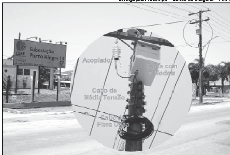
As imagens são transmitidas em tempo real através da rede de comunicação e acesso à Internet pela rede elétrica
