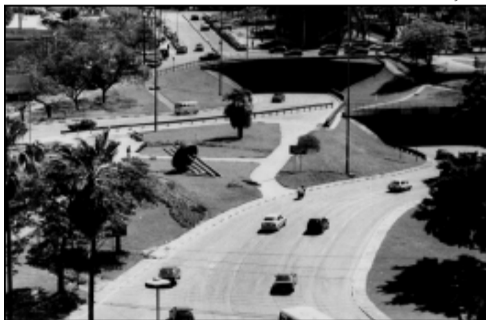
Prejuízos e falta de luz no Túnel da Conceição são consequências de roubos e atos de vandalismo
