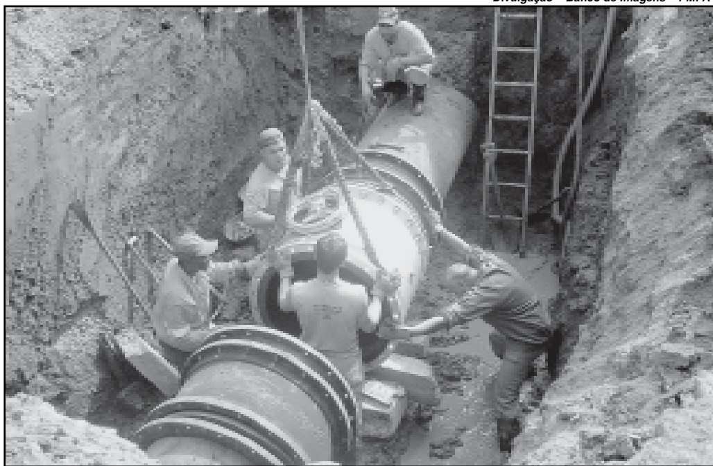
A instalação de macromedidores permite avaliar, com precisão, o volume de perdas de água
