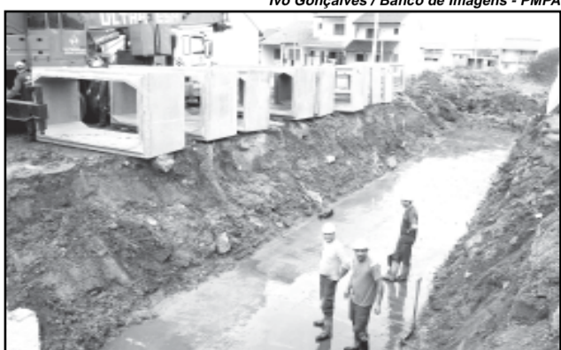
Obras desviam galeria pluvial para um arroio próximo evitando alagamentos
