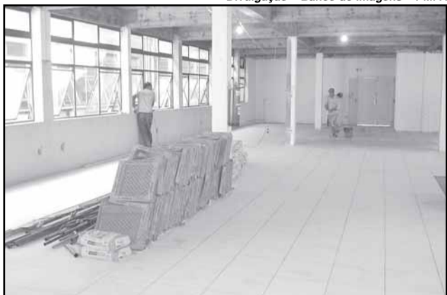
Reforma da área 11 do centro de saúde permitirá instalar 10 consultórios
