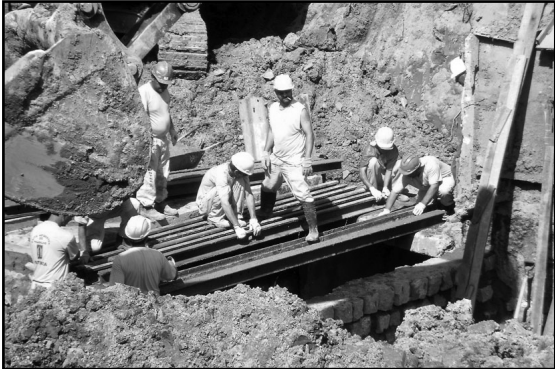
Na Ipiranga, foi construída uma galeria de três metros por 1,50 metro
