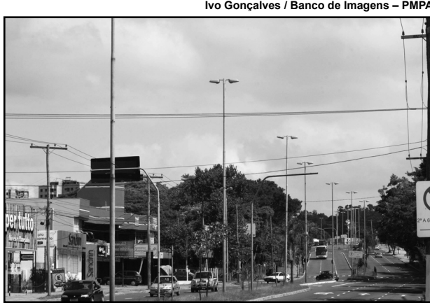
Luminárias foram substituídas em 139 postes da avenida Cavalhada
