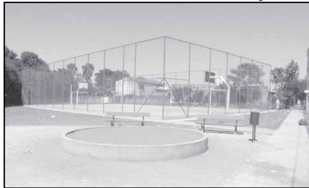
A praça possui 24.892 metros quadrados e foram investidos mais de R$ 216 mil nas obras de recuperação
